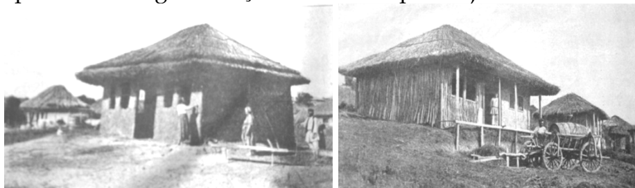
Case de locuit în proces de construcție.
