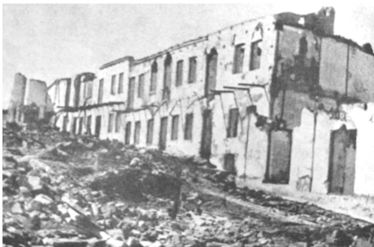
O clădire ruinată din centrul Bălțiului.
